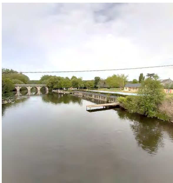
6-Les berges aménagées de la piscine de Marboué
